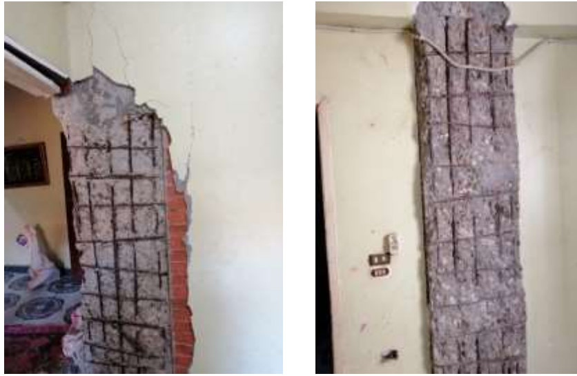
الشكل رقم (2): آثار صدأ حديد التسليح بالأعمدة الخرسانية
